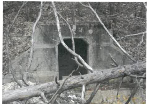
használaton kívüli víziközmű terület bejárata
