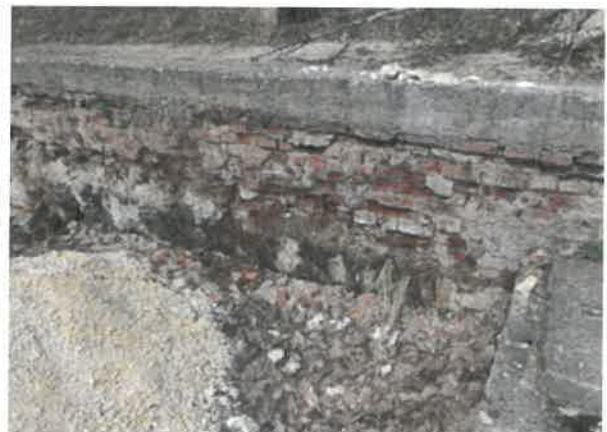
használaton kívüli víziközműhöz kiépített, gyenge állapotú, felújítandó, vagy bontandó támfalak
