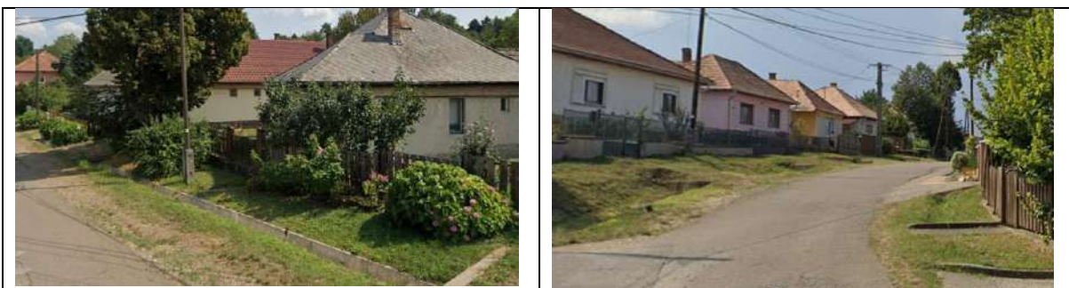
Hársfa utca csapadékvíz elvezetése
