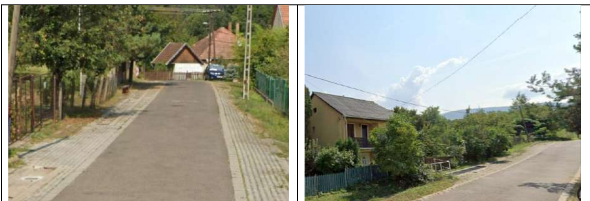
Toldi utca csapadékvíz elvezetése
